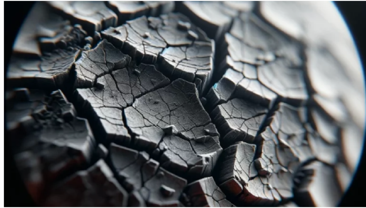
コンクリートのひび割れのチェック
